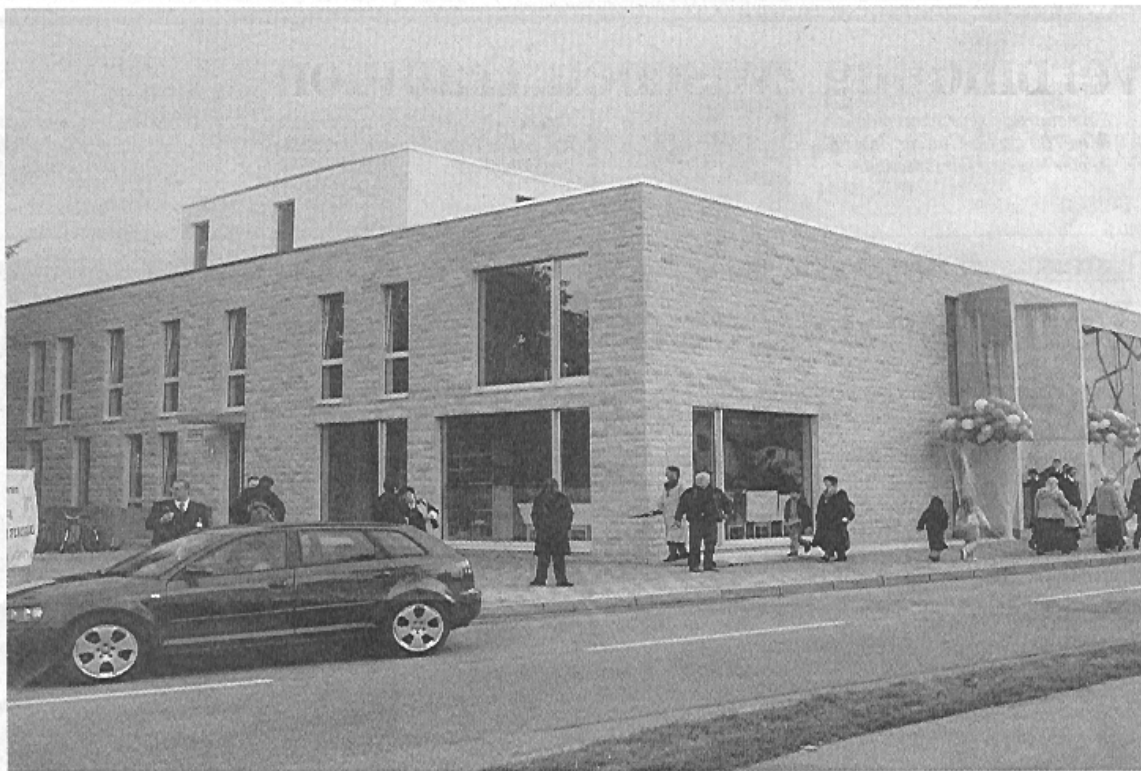
Einweihung: Ca. 2000 Geladene Gäste waren begeistert über die gelungene Außenfassade.
